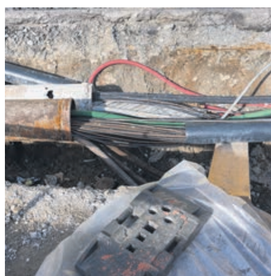
Les fibres optiques ont été déplacées des vieilles conduites vers de nouvelles sur les 170 mètres de longueur de l'ouvrage.
