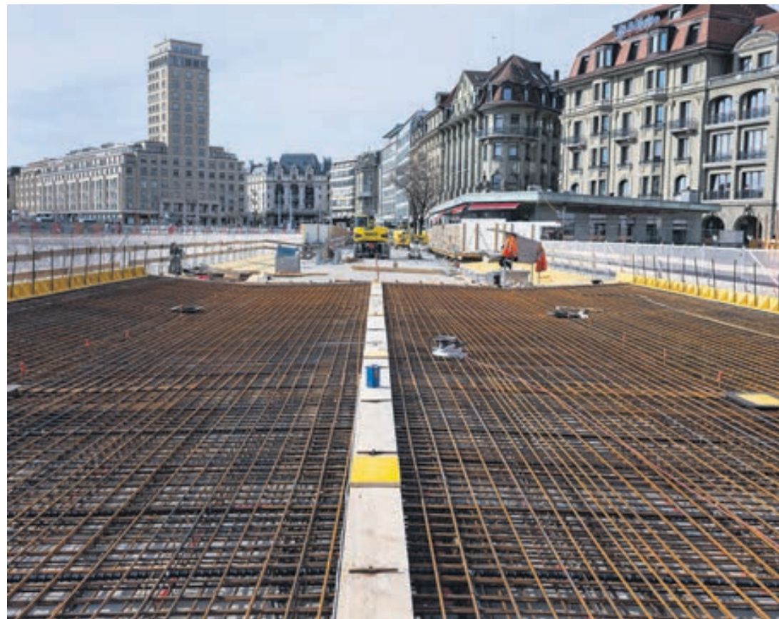
La cage d'armatures, avant le coulage du béton. Le lendemain, le béton sera lavé au karcher pour le rendre rugueux, afin que le revêtement en CFUP adhère mieux.
