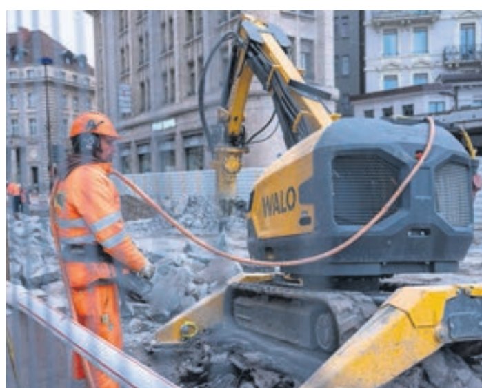
La démolition de la couverture du pont a demandé beaucoup de précision.
