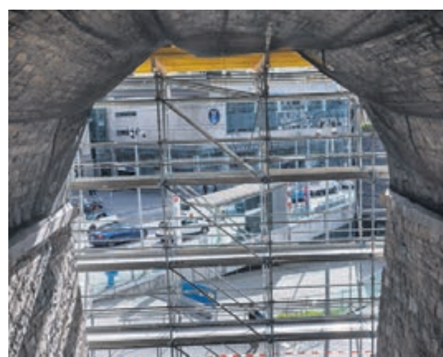
Des filets ont été installés sous les arches pour éviter les chutes de matériaux.
