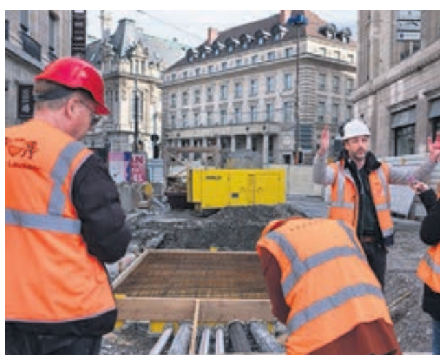
Le chef de projet de la Ville de Lausanne, Cyril Gerbino, explique les spécificités de ce chantier hors du commun.
