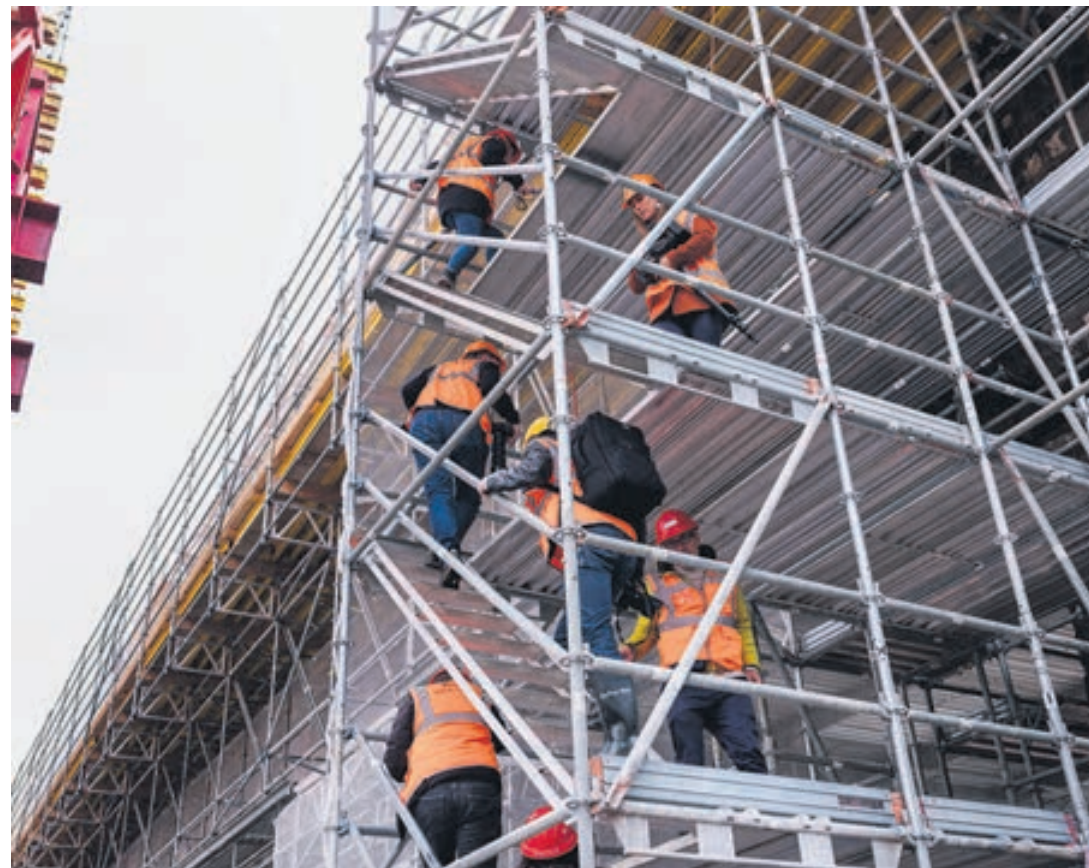
Le 11 avril, les représentants des médias étaient invités à visiter le chantier.
