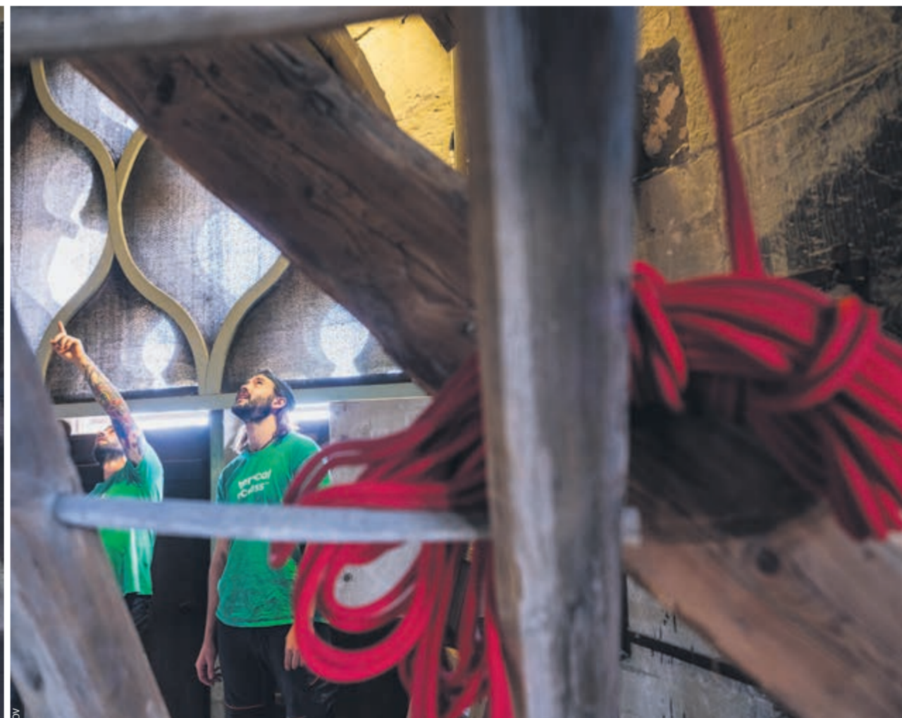
Les cordistes évaluent ensemble le terrain de leur intervention.
