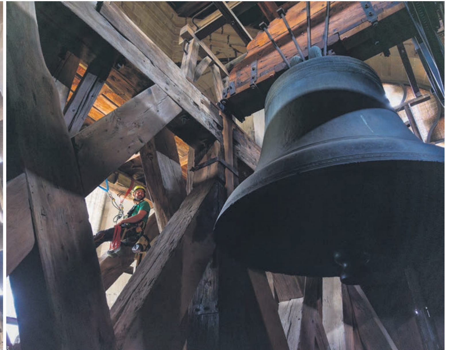
Travail en charpente, dans des salles inaccessibles au public. La variété des lieux d'intervention participe de l'attrait pour le métier.
