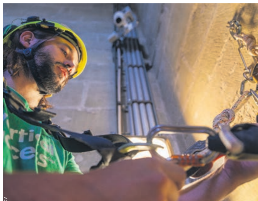
La résistance de l'ancrage a été préalablement vérifiée avec un testeur d'arrachement.
