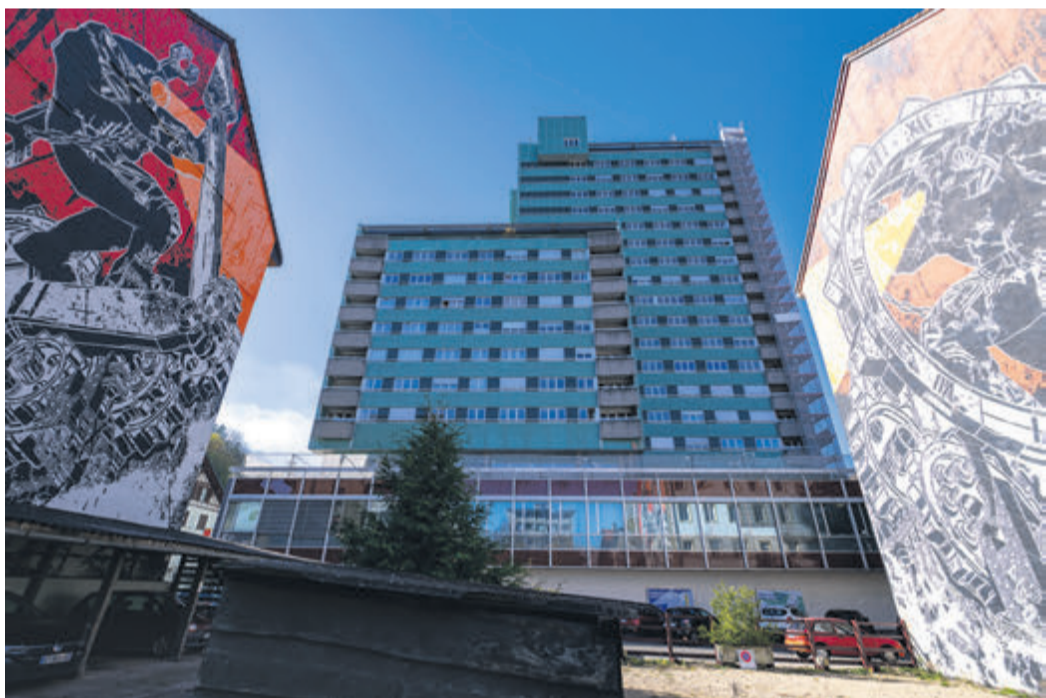
«Les esclaves du temps», par M-City (Pologne): En termes de dimensions, ce diptyque réalisé au spray et au pochoir est la plus grande des fresques de l'exomusée. Sa réalisation a pris deux semaines. Il y avait ici un immeuble qui a été démolit, ce qui a laissé ces deux murs de même taille se faisant face. L'artiste, M-City, est connu pour son graphisme particulier. Les rouages mécaniques évoquent le temps qui passe, avec les personnages qui essaient de l'arrêter.
