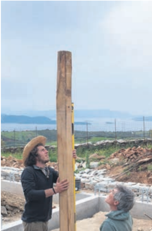
Construction – Avec les conseils d'un ami charpentier, le père et le fils travaillent sur un futur atelier. «Avant, je n'avais jamais rien construit», dit Georges.
