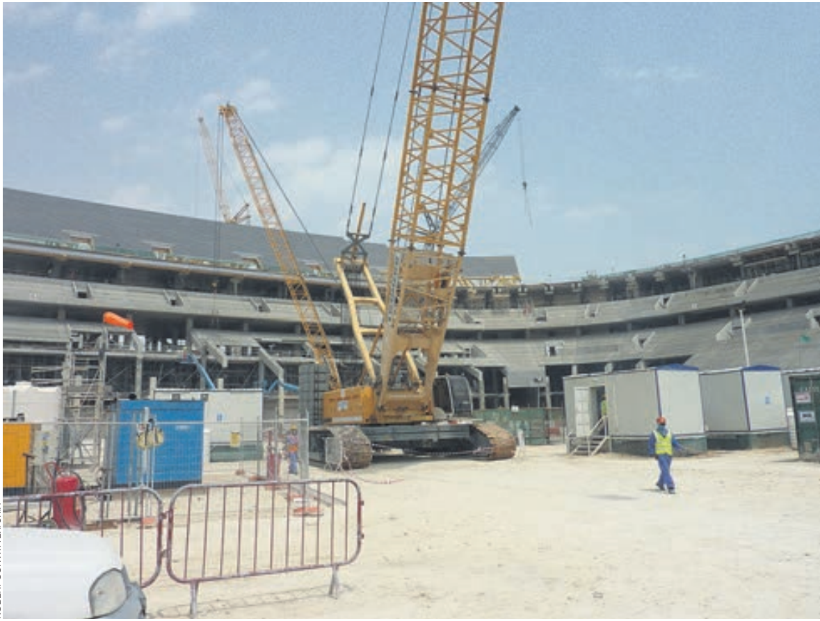
Grâce à l'intervention des syndicats qui ont mené plusieurs inspections sur place, la santé et la sécurité des travailleurs employés à la construction des stades ont été améliorées. Avec l'aide d'autres partenaires, l'IBB a aussi contribué à l'abandon du système de la kafala .
