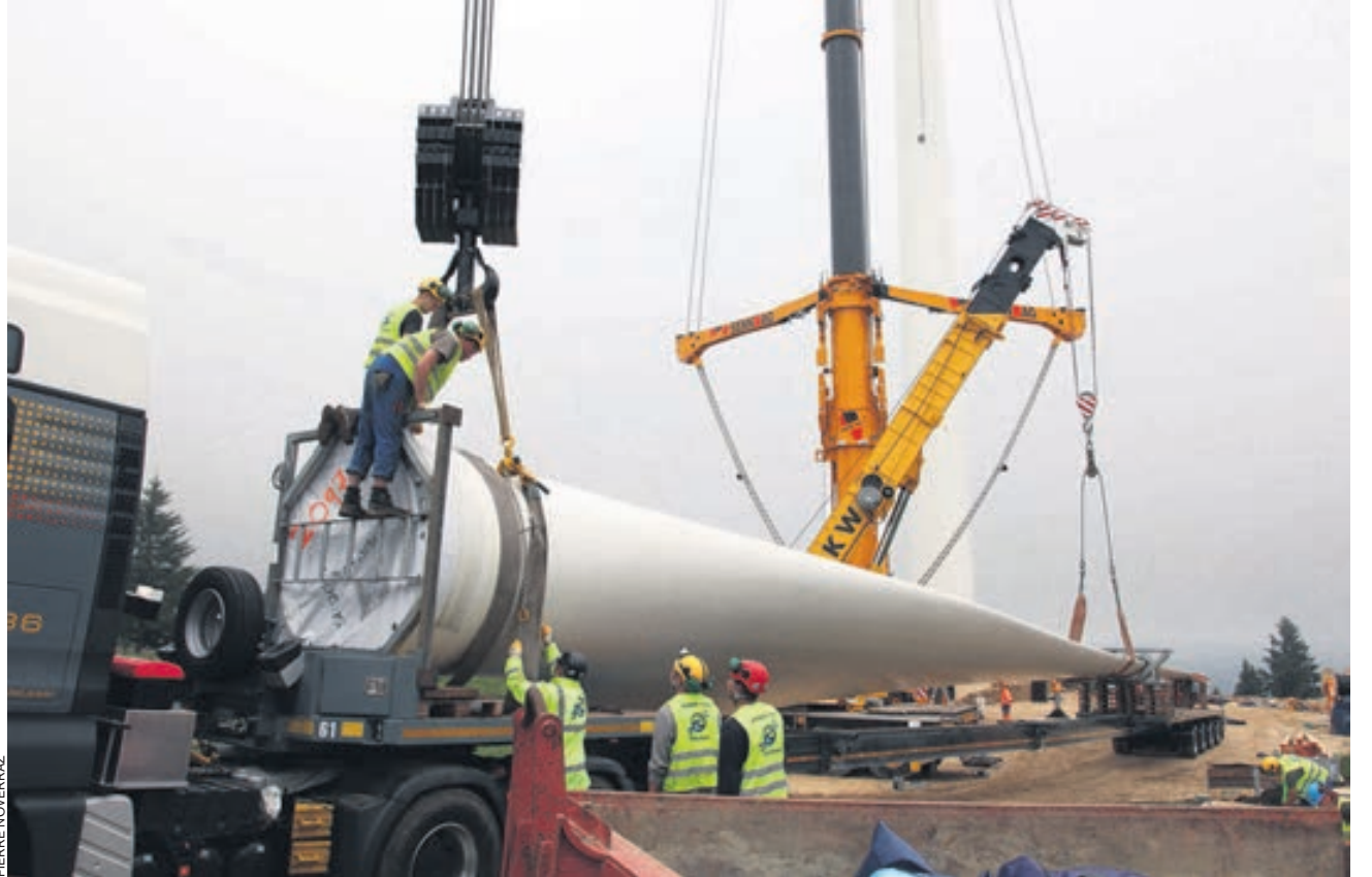
Valoriser les énergies propres, que ce soit le soleil, l'eau, la chaleur du sous-sol ou le vent, permettra de faire face aux défis climatiques et à la crise énergétique, mais favorisera également la création d'emplois. Ici, le montage d'une des éoliennes du Mont-Crosin, dans le Jura bernois, en 2010.
