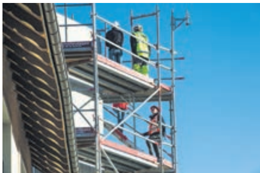
Unia exige un minimum de trois travailleurs par équipe pour le montage des échafaudages. A deux, les risques sont beaucoup trop importants, même si les ouvriers disposent de harnais de protection.
