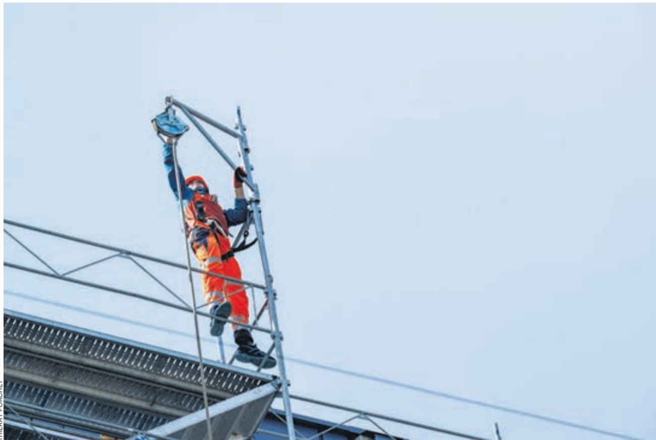
Les échafaudageurs ont un rôle clé sur les chantiers. Ils assurent la sécurité de tous les acteurs qui y travaillent. Mais trop souvent, leur propre sécurité n'est pas assurée et les risques encourus ne sont pas reconnus dans leur rémunération.
