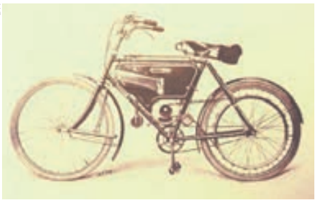
Les frères Dufaux ont puisé dans le savoir-faire horloger pour créer leur moteur de bicyclette, glissé dans une sacoche.
