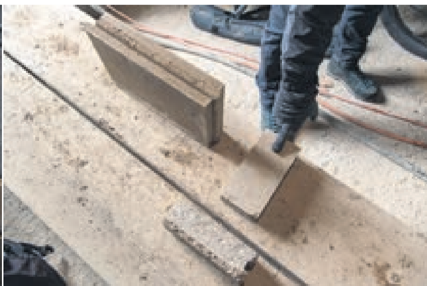
Oxara collabore notamment avec l'entreprise Terrabloc à Genève. Ici, un maçon monte une cloison avec des briques de terre crue.
