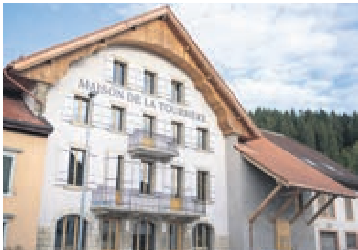
Ouverte en décembre aux Ponts-de-Martel, la Maison de la Tourbière sert d'écrin à un espace muséal, un centre de compétences et un hôtel-restaurant.
