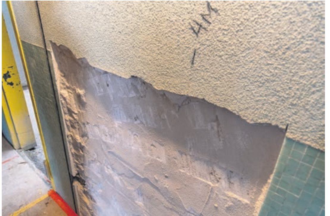
Sur ce mur, le carrelage a été retiré au marteau-piqueur, alors que des ouvriers travaillaient juste à côté, sans protection, notamment dans l'embrasure de la porte.
